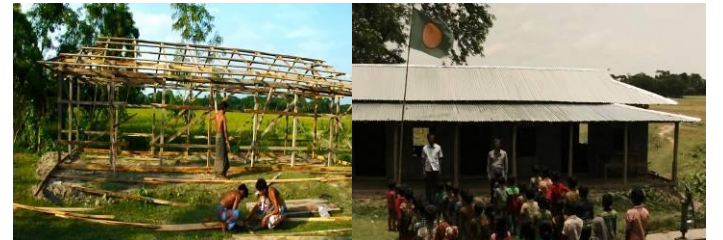
১ম: স্কুলের ভবন নির্মাণ এর কাজ চলছে ২য়: ভবন নির্মাণ শেষে স্কুলের স্বাভাবিক কার্যক্রম
