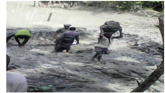
নাগরিক কমিটির উদ্যোগে রাস্তার ভাঙতি মেরামতের কার্যক্রম চলছে
